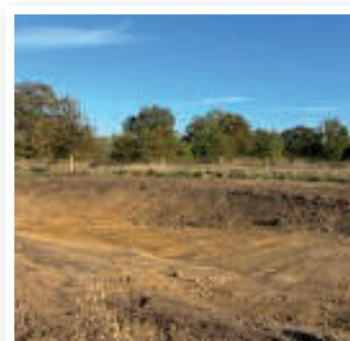
Pendant les travaux
