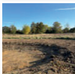
Pendant les travaux
