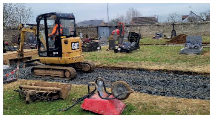
Pendant les travaux.
