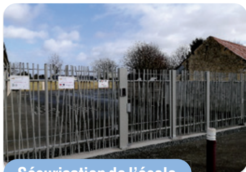
Sécurisation de l'école
