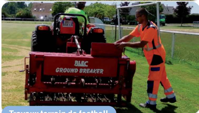
Travaux terrain de football
